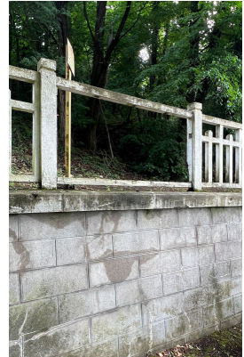
Eléments de garde-corps manquants
