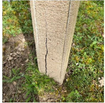
Emblèmes fendus, cassés, non réparables, prévu remplacés
