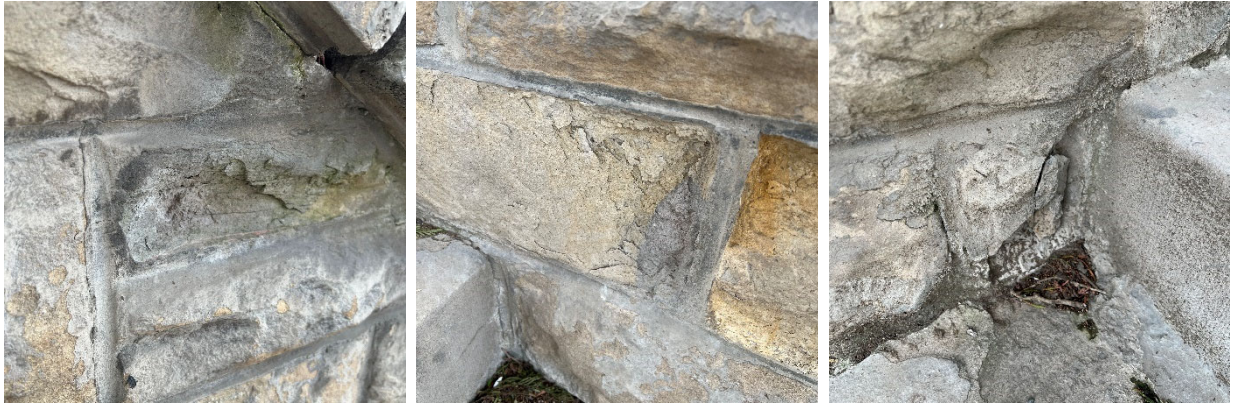
Mur en pierres : pierres friables, abimées, joints ouverts
