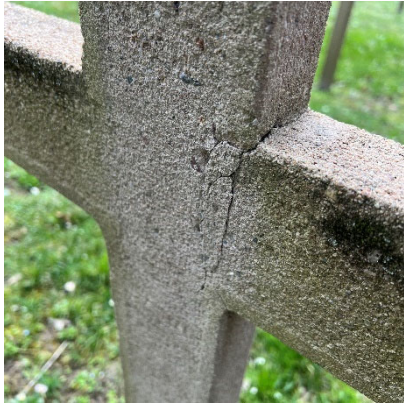
Emblèmes fendus, cassés, non réparables, prévu remplacés
