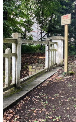
Eléments de garde-corps manquants
