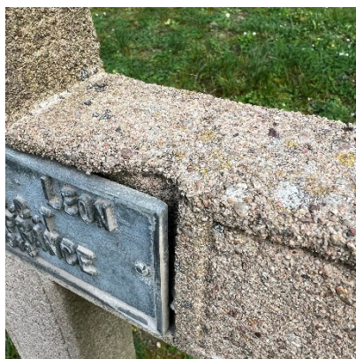
Emblèmes restaurables, via petites réparations au ciment (petites épaufures)
