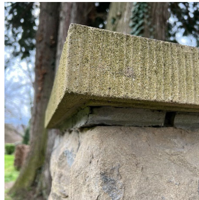
Margelles cassées, margelles descellées
