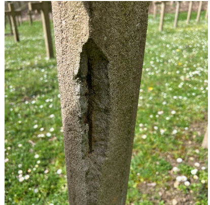
Emblèmes avec éclatements du béton, fers à nu, prévu remplacés
