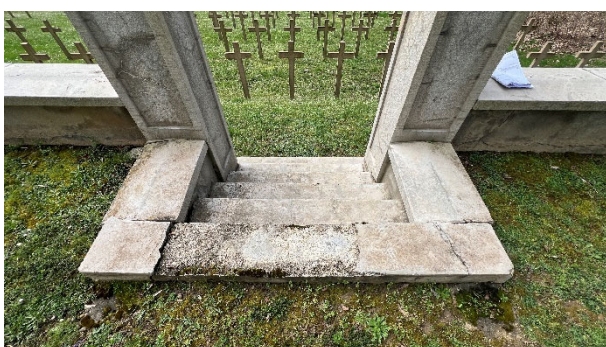
Mur périphérique : fissurations « fermées » ou « ouvertes »
