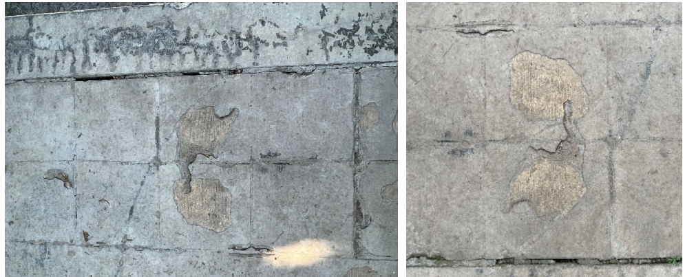
Dallage pierre d'arrivée, épaufrures, badigeon ciment
