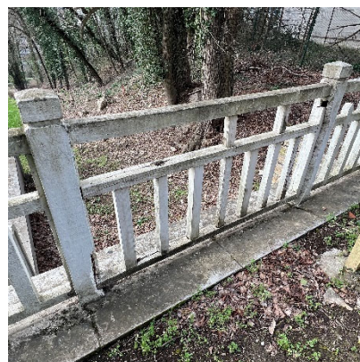
Garde-corps en barrières / clôture béton préfabriqué
