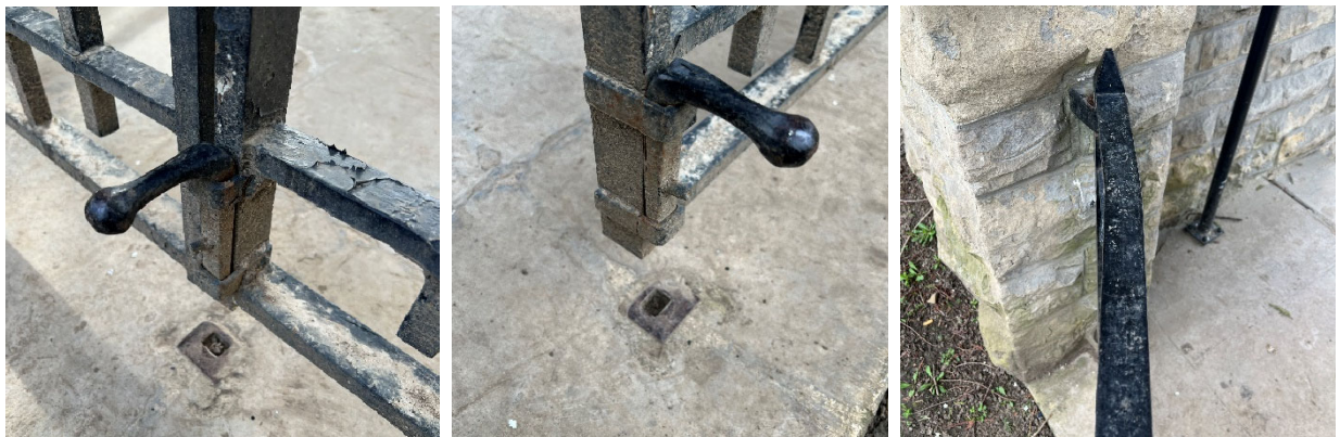
Portillon : A gauche, loquet cassé / A droite, vantail droit déformé
