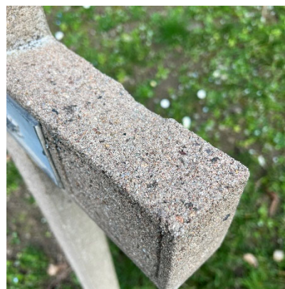
Emblèmes restaurables, via petites réparations au ciment (petites épaufures)
