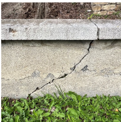
Mur périphérique : fissurations « fermées » ou « ouvertes »
