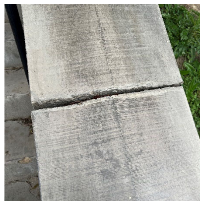
Joints ouverts, épaufrures, badigeon ciment
