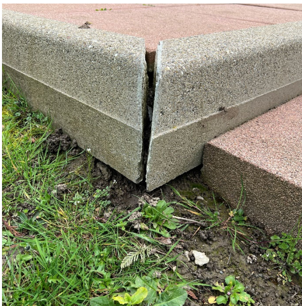
Déchaussements des bordures, des dalles
