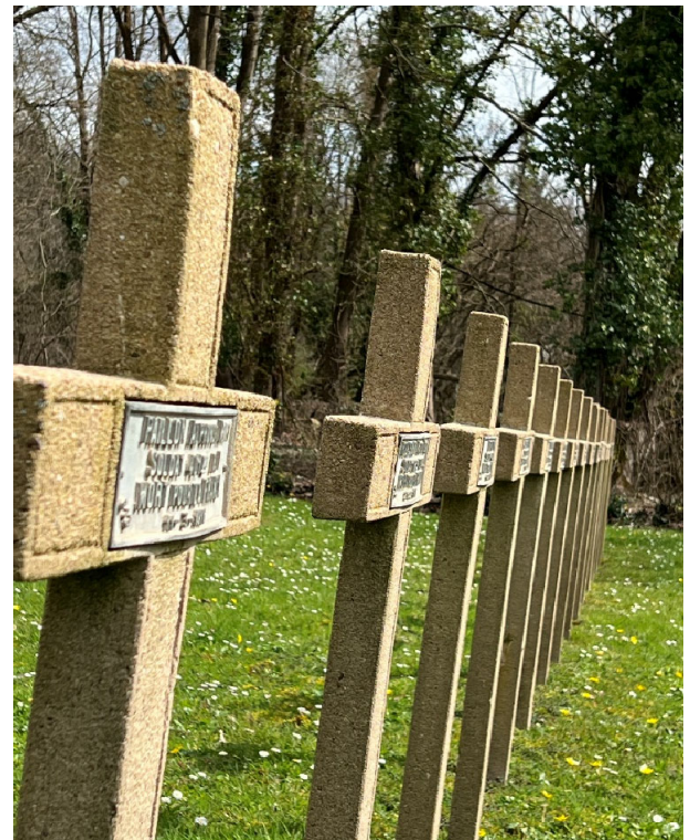
Désalignement et inclinaisons des emblèmes
