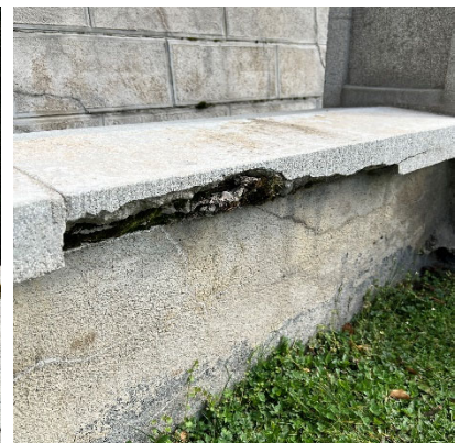
Margelles granito : état dégradé généralisé
