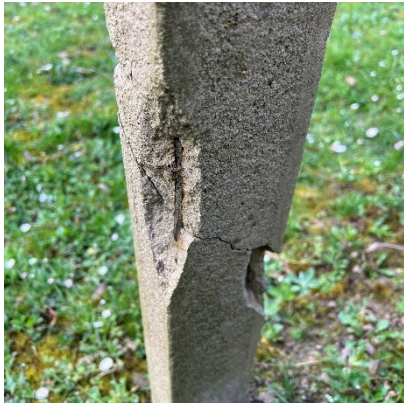
Emblèmes avec éclatements du béton, fers à nu, prévu remplacés
